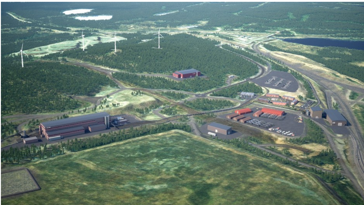
Figur 3. Schematisk bild av kommande verksamhet. Längst till vänster kommer anrikningsverket att byggas. Till höger ligger förrådsbyggnader och kontorsbyggnader. Den röda byggnaden högst upp i mitten i bild är vattenreningsverket. I förgrunden ligger det gamla sandmagasinet, som kan komma att anrikas med så kallad re-mining.
